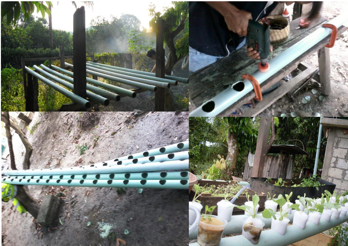
Figura 1- Construcción de la estructura cultivo NFT.
