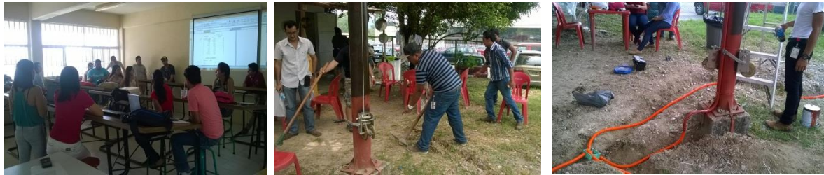
Figura 6, 7, 8. Observamos en las siguientes imágenes el rendimiento del taller e instalación del tendido eléctrico sobre la zona seleccionada. Fuente: Morales 2016.
